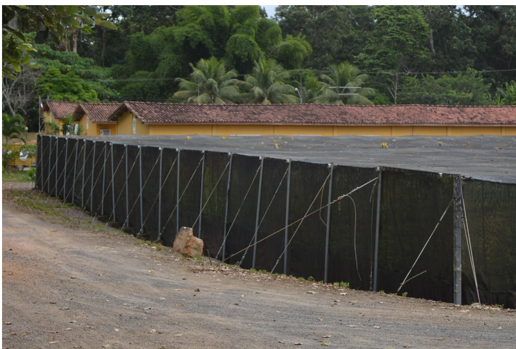
Postes e cabos substituídos | Foto: Mariana Ferreira/Ascom IBC
