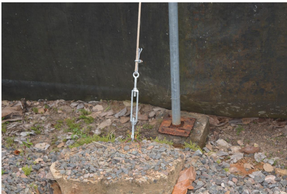
Esticadores de cabo substituídos | Foto: Mariana Ferreira/Ascom IBC
