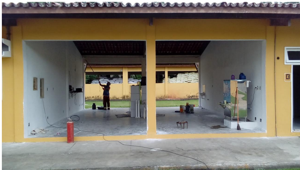
Reforma do espaço multiuso | Foto: Mariana Ferreira/Ascom IBC
