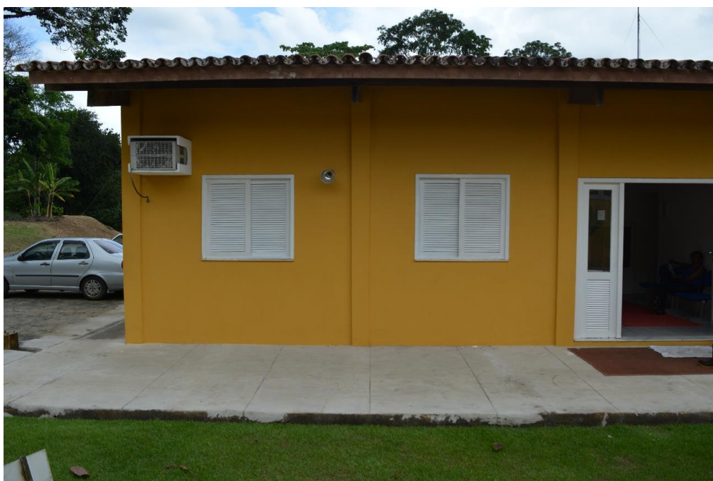
Piso reformado e pintura da sede | Foto: Mariana Ferreira/Ascom IBC
