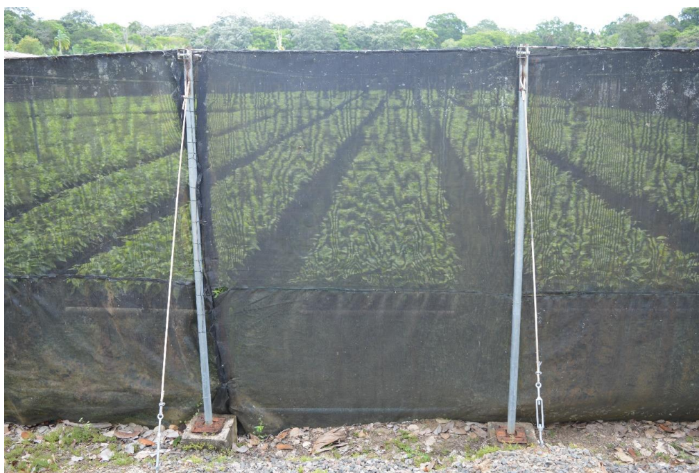
Postes, cabos e esticadores de cabos substituídos | Foto: Mariana Ferreira/Ascom IBC
